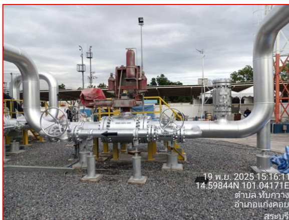
จุดเปิด-ปิดการจ่ายก๊าซ บริเวณแนวท่อ สถานีควบคุมก๊าซ WK 5
