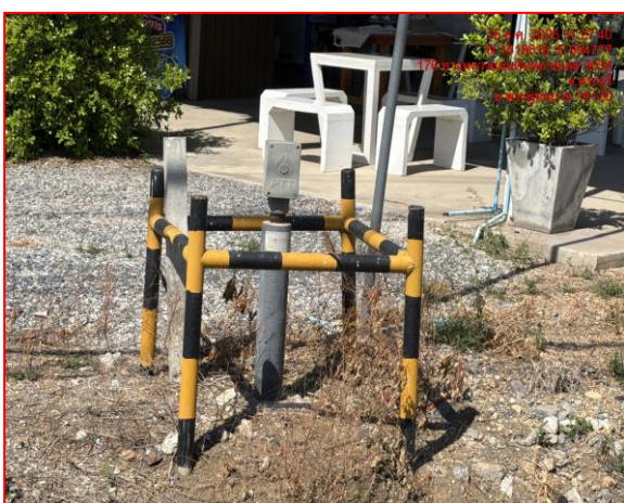
รั้วเหล็กกันจุด Test Post
